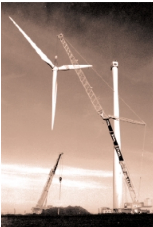
Der 16,5 t schwere Rotor wird auf den Stahlrohrturm gehievt.
